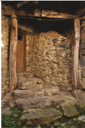
Vista hornera y escalera (espacio interior)
