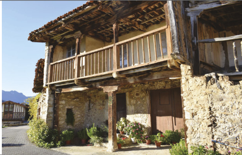
Fachada este (principal)
